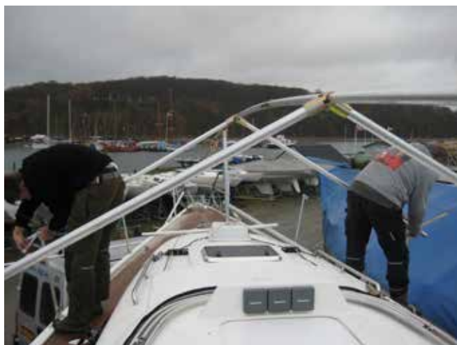
Spær monteres og spændes ved septer.
